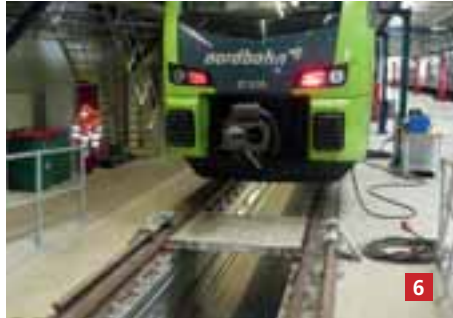
6. Gleisplatten, 2 Stück zum sicheren Überqueren der Gleisgruben
